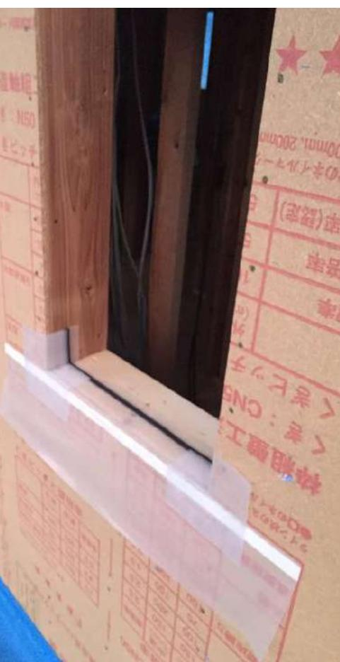
3-3□防水テープの幅は、適切な寸法のものを使用する。
