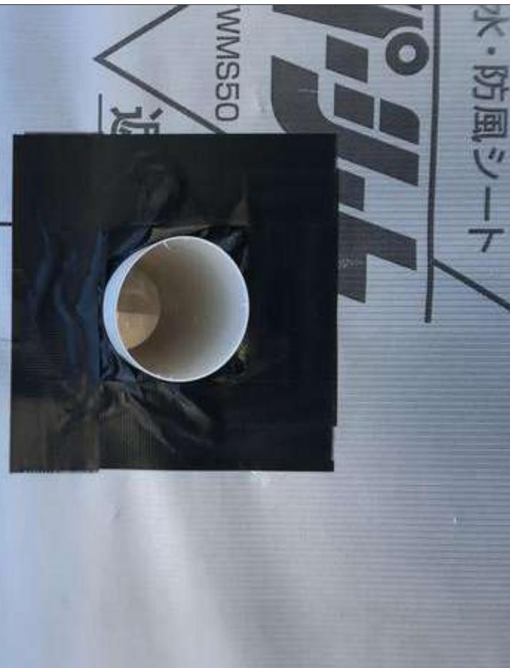
3-11 配管、配線が2本以上貫通する場合は、さや管を使用し、防水措置を適切
