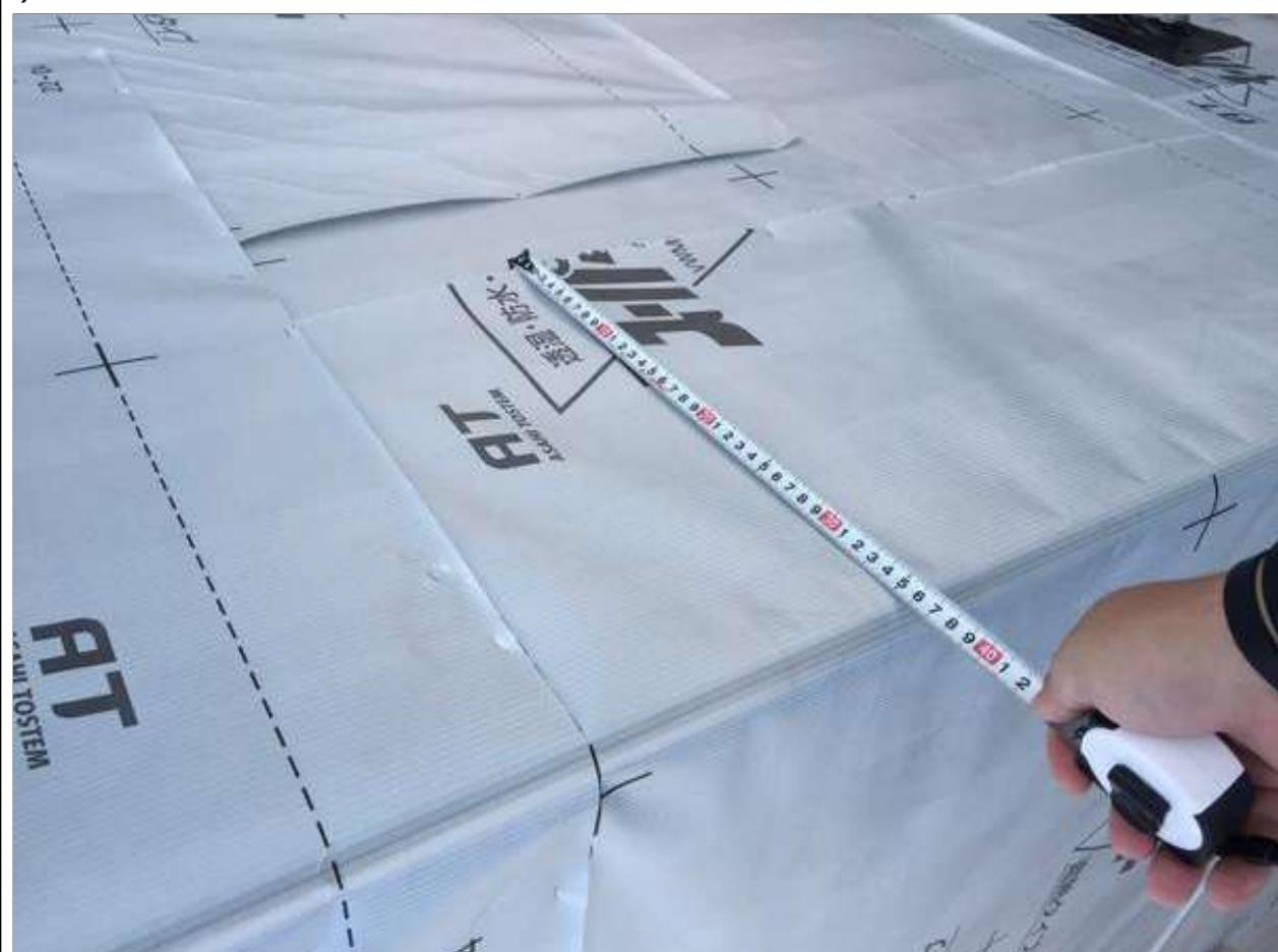
2-5□防湿層（気密シート）は幅広の長尺シートを用い、連続させ、隙間の出ない
