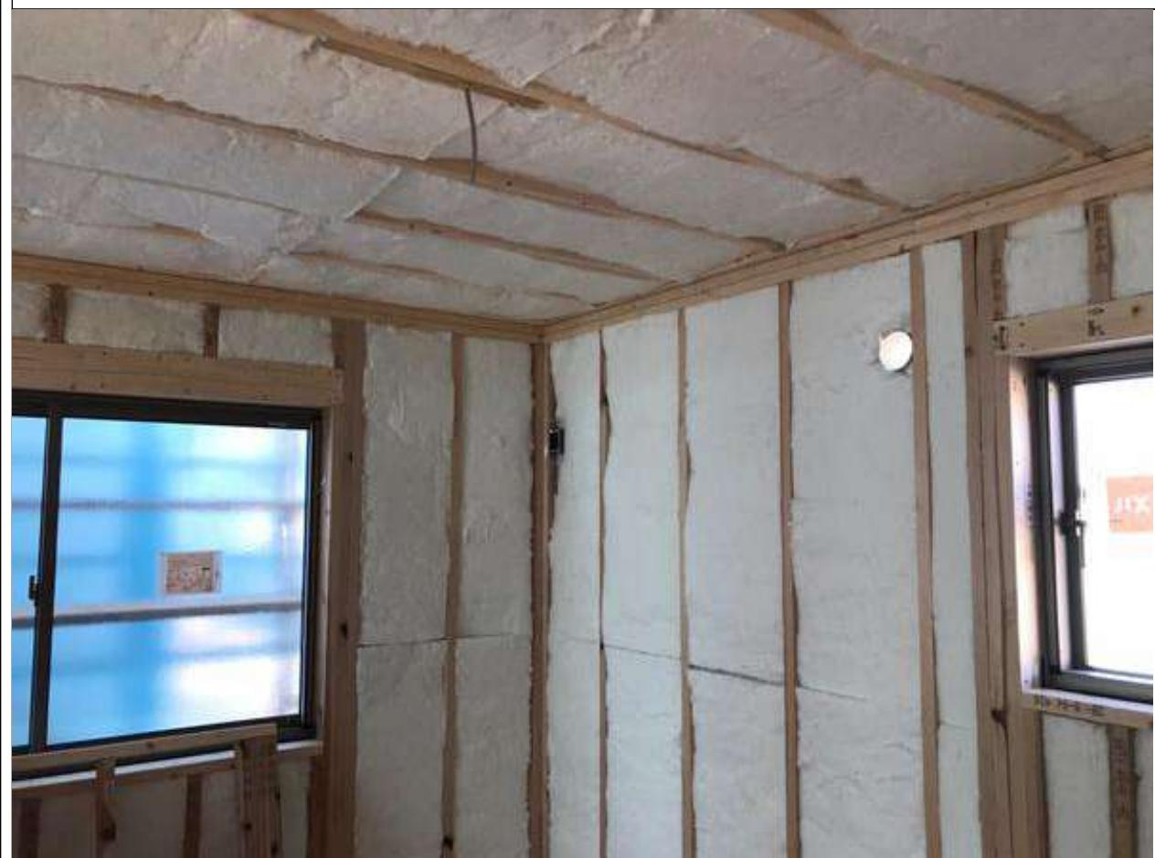
2-3□断熱材は隙間・欠損・施工不良がないように施工する。 断熱材は配管部分に隙間がないように気を付ける。(2/2)
